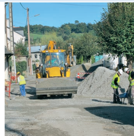
Les travaux rue du Canal en octobre
