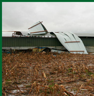
Hangar détruit par la tempête Klaus de 2009. Photo prise en Béarn.
