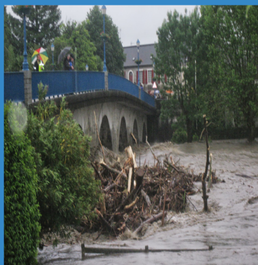
Embâcle sur le pont de Nay le 18 juin 2013
